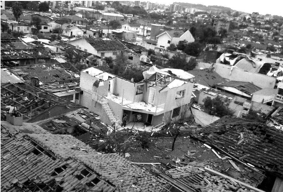
Destelamento em Xanxerê/SC. Foto: Defesa Civil Estadual/SC.
